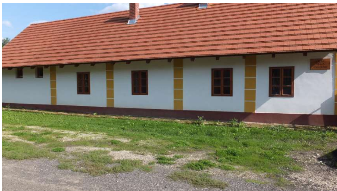
(Vikár Béla emlékház felújítás után)
